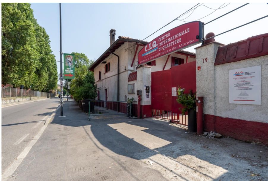
fig. 32 – Cascina Casottello, sede del C.I.Q., vista da via Fabio Massimo
