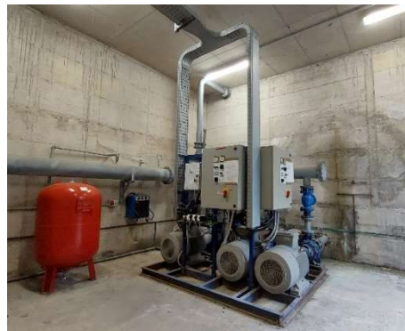
Vasca antincendio interrata (a sinistra), gruppo di pompaggio vasca (a destra)
