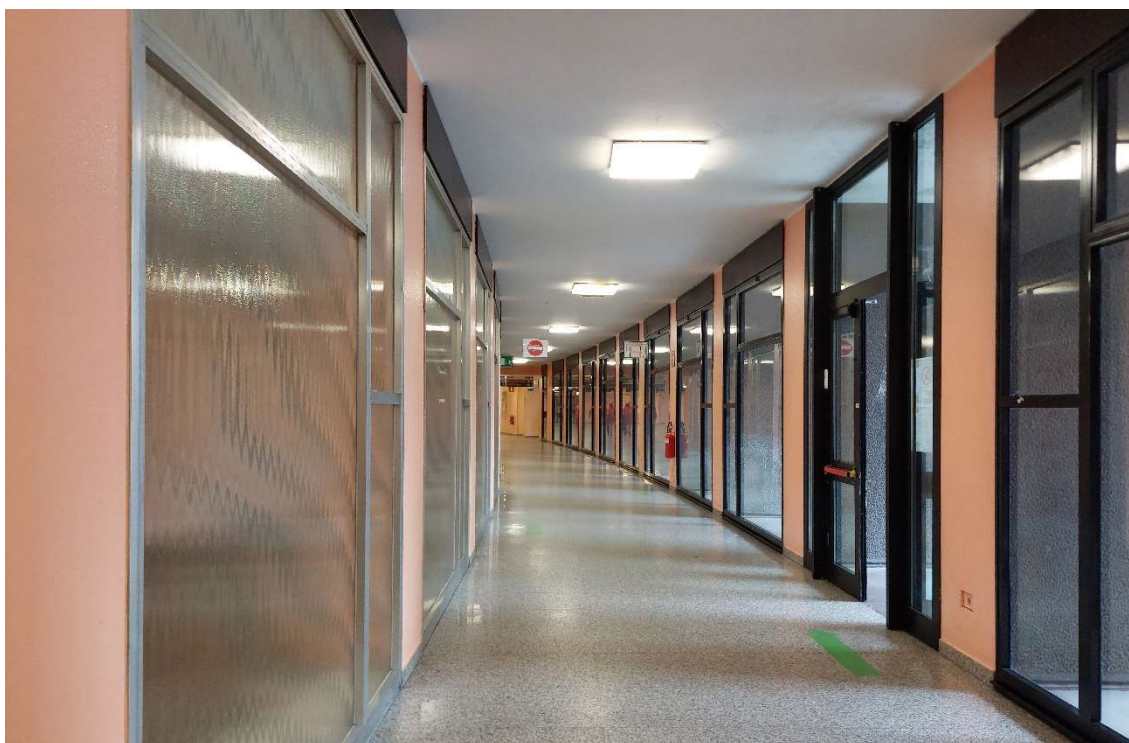
Fotografia 14: Policlinico Satellite, corridoio di distribuzione piano terra corpo centrale
