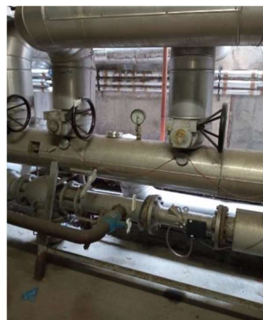
Sottocentrale ex centrale termica-arrivo teleriscaldamento (a sinistra); sottocentrale padiglione Infettivi—arrivo teleriscaldamento emergenza (a destra)
