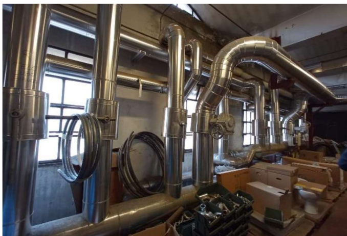
Sottocentrale ex centrale termica-arrivo teleriscaldamento (a sinistra); sottocentrale padiglione Infettivi—arrivo teleriscaldamento emergenza (a destra)
